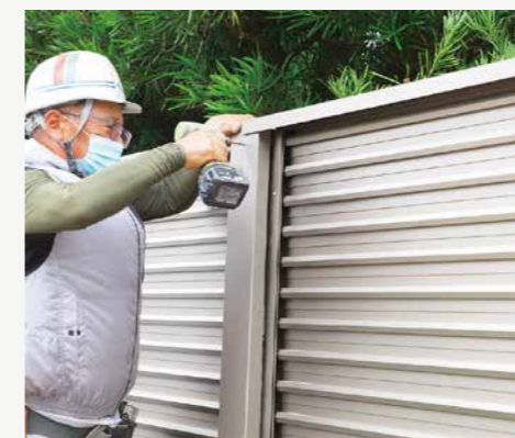
コンクリートビスにて 支柱カバーの取付
