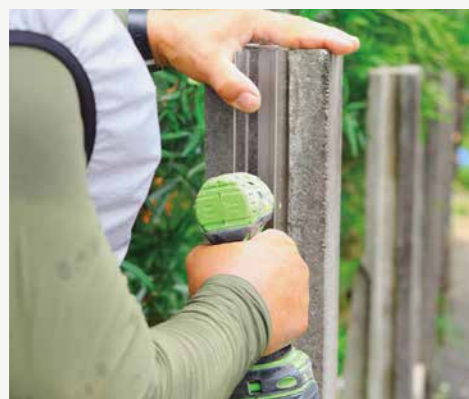
コンクリートビスにて 取付枠の取付
