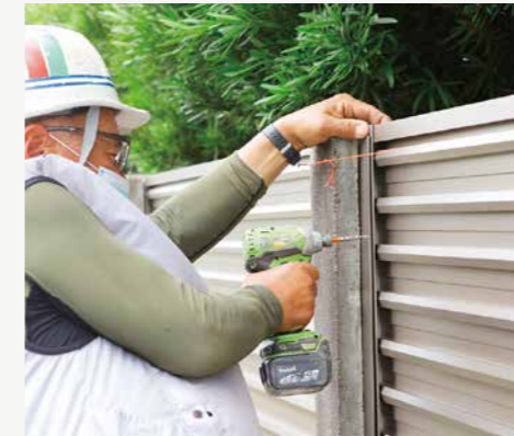
パネル固定用穴加工 高さを合わせる
