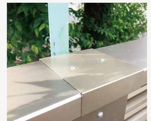
笠木ジョイントの取付 テックスビスにて笠木に取付
