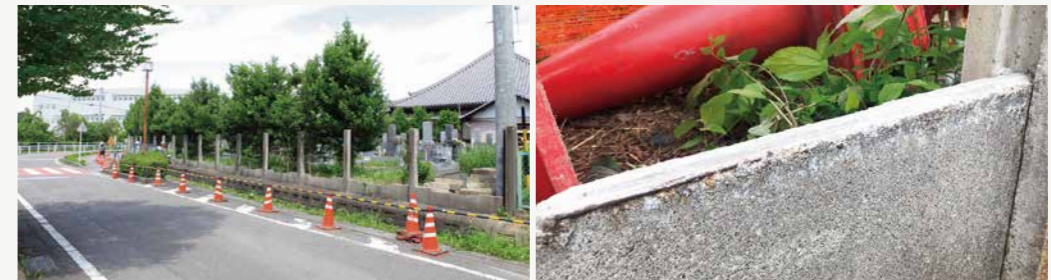
パネル撤去後
