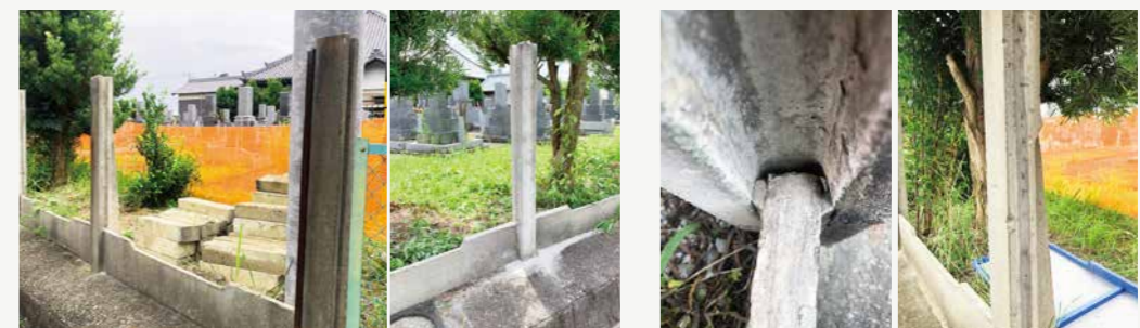
既設モルタル等の除去
