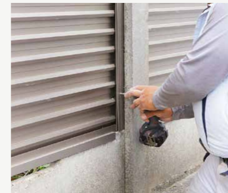
パネルの固定
