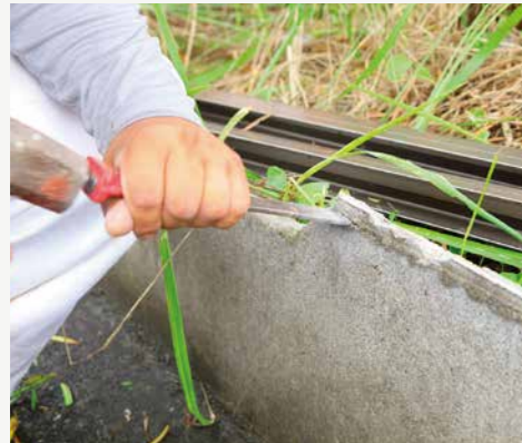
既設モルタルの除去
