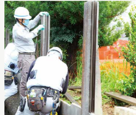
取付枠の高さ調整
