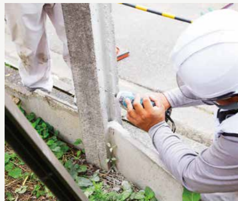
既設支柱へ取付枠用の穴加工
