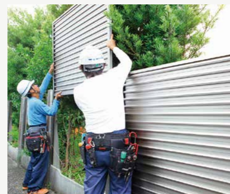
パネルの挿入 上部から取付枠の間に上から差し込み
